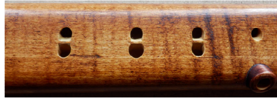
Abb. 8 Eckige Form, Versuch, die Tonlöcher näher aneinander zu bringen
