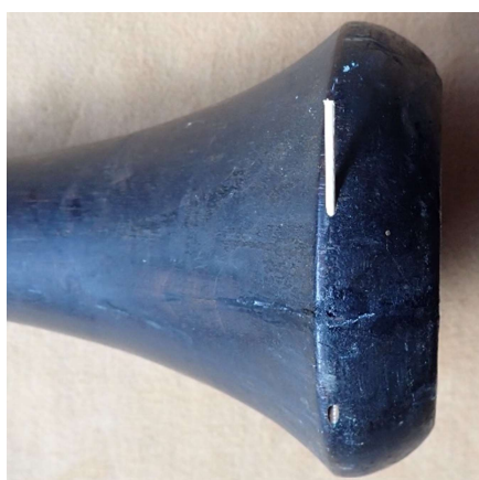
Risssicherung mit Bambusstift
